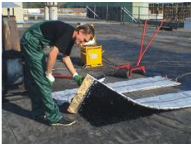
Рис. 3.4. Разогрев водоизоляционного ковра
