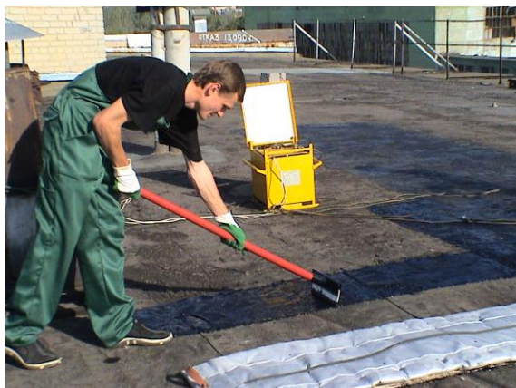
Рис. 3.5. Выравнивание разогретого водоизоляционного ковра
