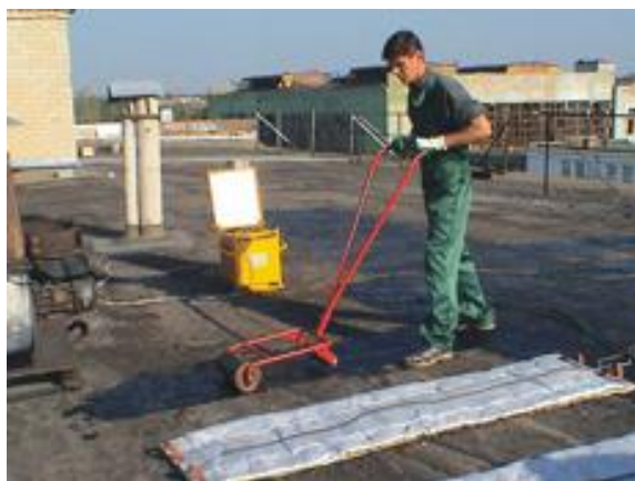
Рис. 3.6. Прикатка разогретого водоизоляционного ковра
